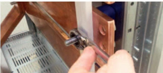
3. Zur besseren Erreichbarkeit der Verbindungsstellen können die Türen ausgehängt werden: hierfür wird zuerst der Scharnierbolzen von unten herausgedrückt, anschließend können die Türen im 90° Winkel ausgehängt werden.
