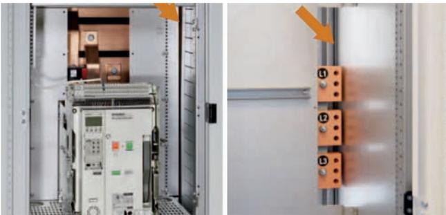
2. Das Lockern der Befestigungen (Mutter M10) auf den blauen Sammelschienenhaltern erleichtert das Ineinanderschieben des Sammelschienensystems.
